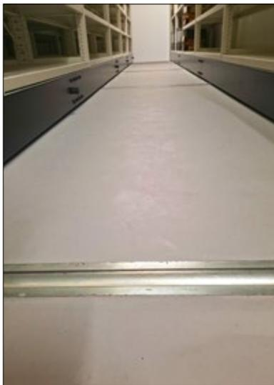
Abb. 2: Schienenabdeckung der Regalanlage (Foto: K. Schubert)
