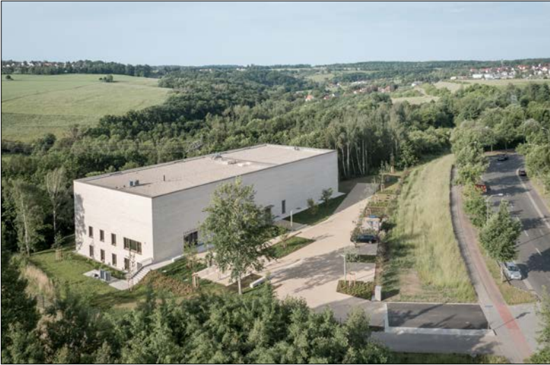
Abb. 1: Das neue Landeskirchliche Archiv Dresden in einer Luftaufnahme (Foto: Till Schuster)
