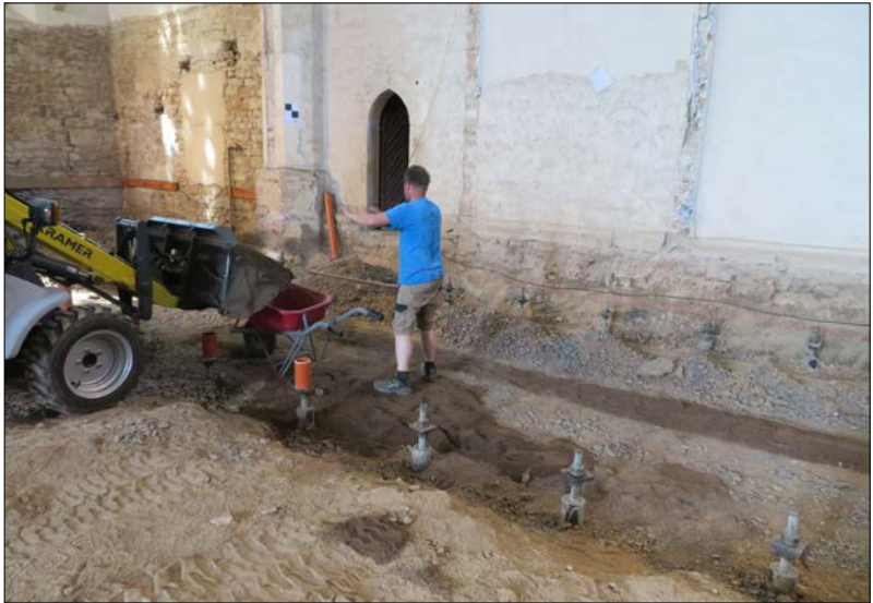
Abb. 5: Ausschachtung für das Archivfundament (Foto: Margit Scholz)
