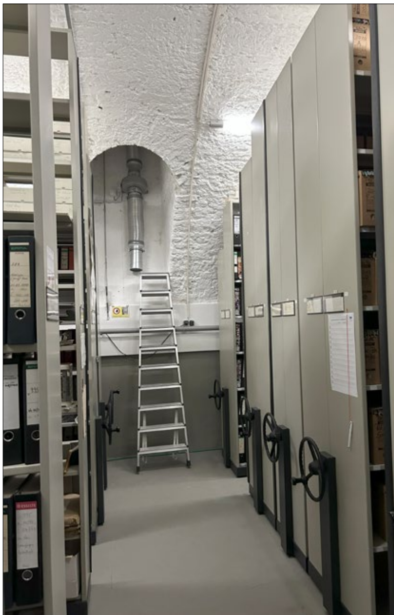
Abb. 6: Innenansicht vom „Gewölbekeller“ nach der Sanierung (Foto: S. Sternemann)
